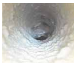
Umazan prezračevalni kanal v bolnišnici
